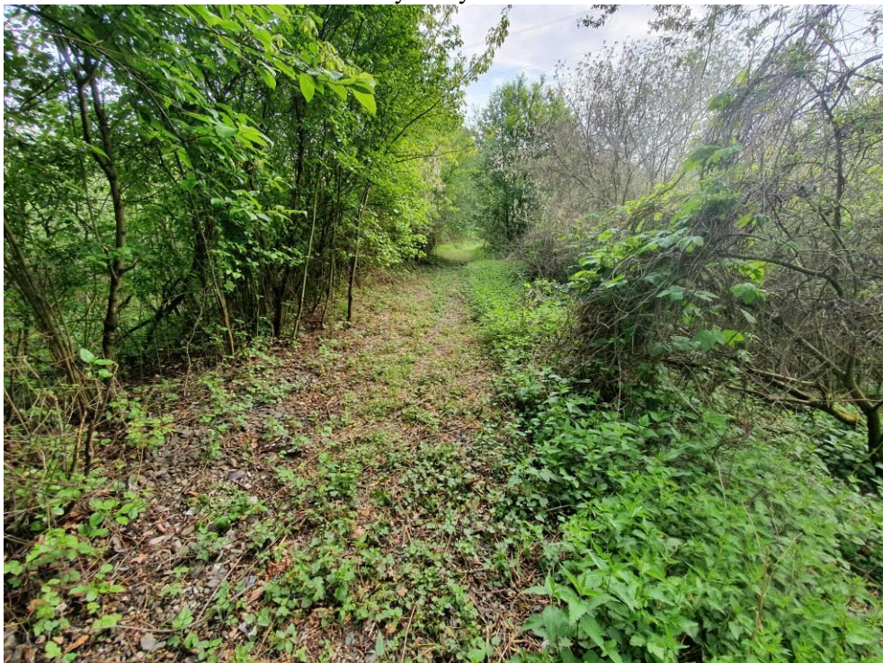
Foto 8: Těleso staré železniční vlečky ve východní části navrženého železničního koridoru.
