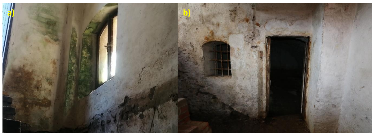
Obr. 26 Degradace v části sklepních prostor využívaných jako lednice – a) biologická a fyzikální degradace u vstupu, b) koroze zdiva, kovových i dřevěných profilů
