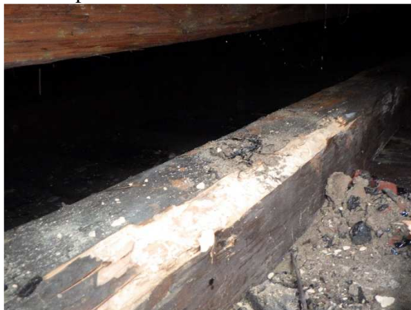
Foto č. 5 a 6 – sonda NV 2 – celkový pohled a detail napadení
