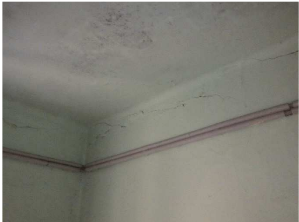
trhlina přes celou šířku zdiva v lokalitě přístavby (dílny)
