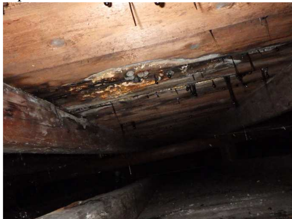
poškození střešního pláště
