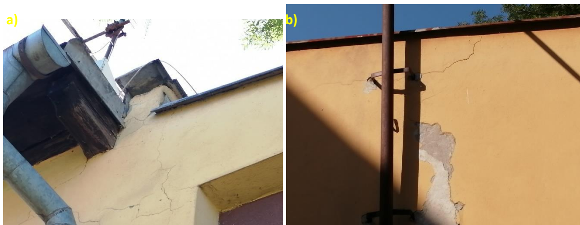
Obr. 19 Degradace v detailech ploché střechy a atiky – a) chybně provedený detail oplechování, b) vznik trhliny u napojení nadzemního elektrického vedení
