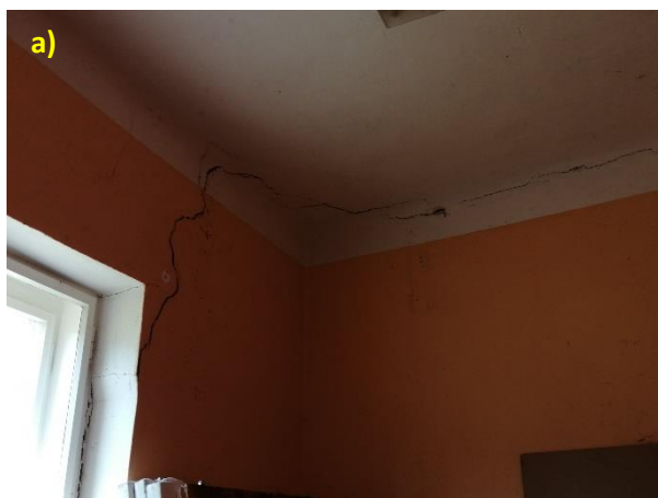
Obr. 6 Trhliny v interiéru původní části objektu
