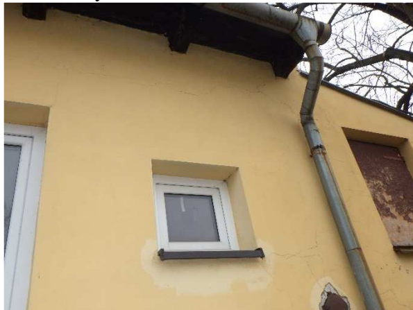
Foto č. 19 - 22 – prohlídka na severozápadní straně, trhliny v konstrukci
