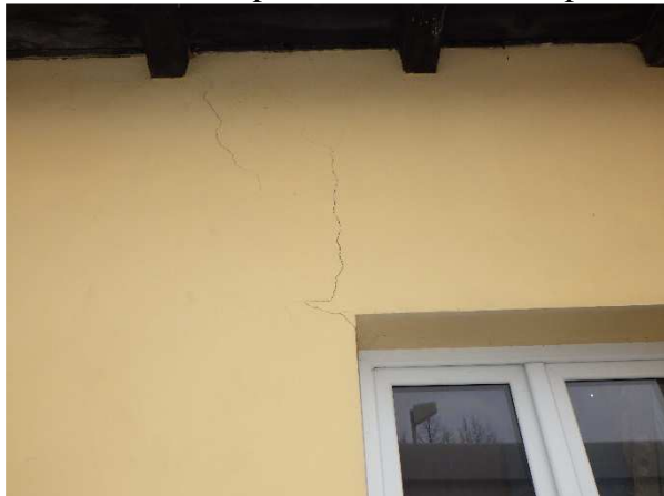
Foto č. 19 - 22 – prohlídka na severozápadní straně, trhliny v konstrukci
