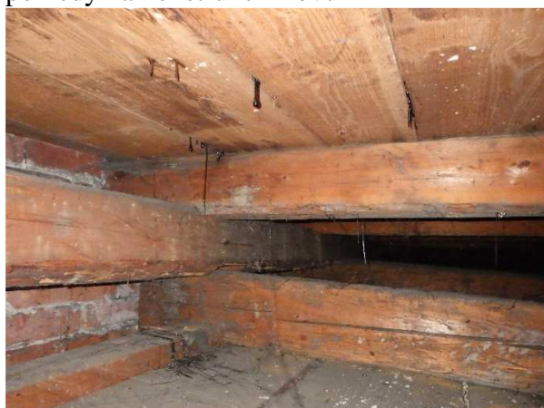
napadení bednění
