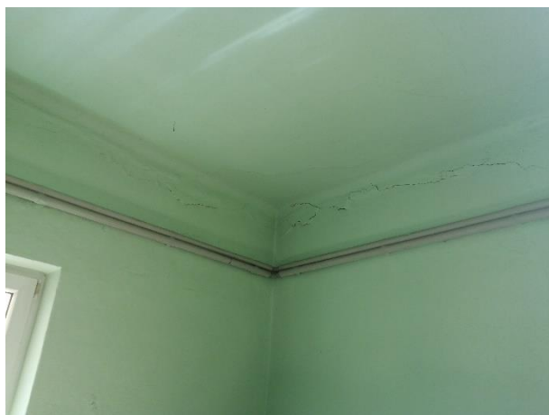
Obr. 24 Trhliny vzniklé deformacemi střešní konstrukce a nedostatečným propojením původní části s přístavkem dílny
