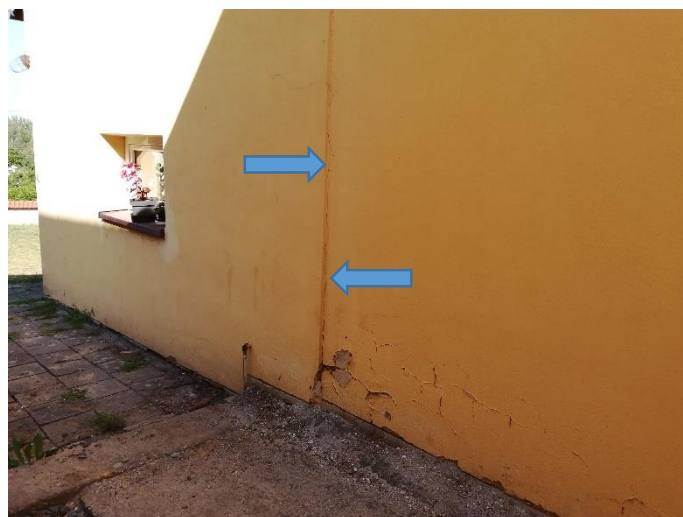
Obr. 20 Nedostatečné propojení nové a původní části ledovny s kuchyní a dílny
