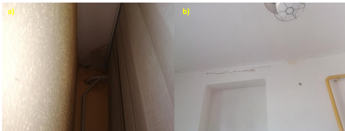
Obr. 23 Zatékání přes střešní plášť – a) vlhkostní mapy u okenního otvoru, b) zatékání v místě atiky spojené se vznikem deformací a trhlin
