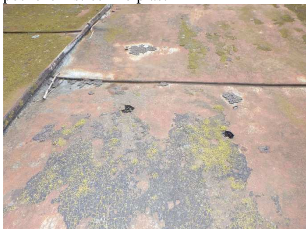
poškození střešního pláště
