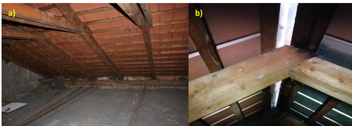
Obr. 10 Krov objekt – a) pohled do konstrukce krovů s uvolněnými táhly, b) uvolněný tesařský spoj
