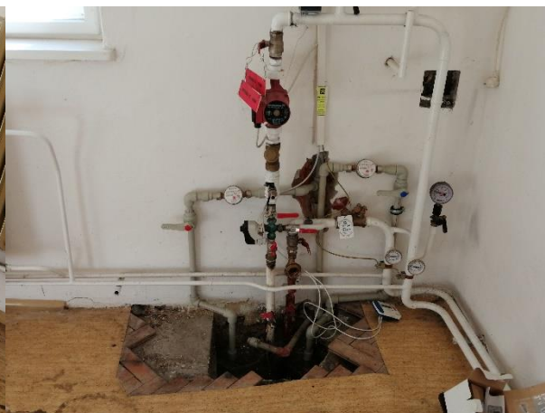
Obr. 8 Nestandardní rozvody instalací
