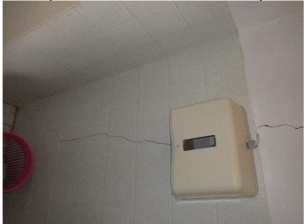
trhlina přes celou šířku zdiva v lokalitě přístavby (dílny)
