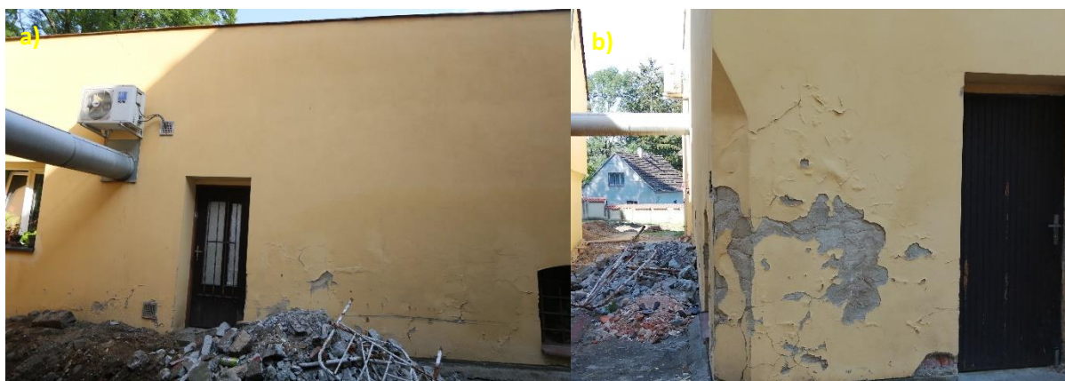
Obr. 16 Vzlínající vlhkost v objektu lednice a vrátnice – a) vlhkostní mapy na jihovýchodní straně objektu, b) fyzikální degradace východního nároží
