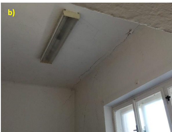
Obr. 6 Trhliny v interiéru původní části objektu
