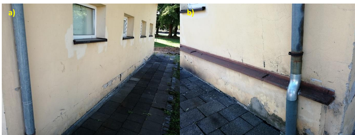
Obr. 17 Vlhkostní degradace v exteriéru objektu lednice a vrátnice – a) zvýšená vlhkost zdiva pod realizovaným sanačním opatřením, b) působení odstříkující vody a vliv zvýšené vlhkosti pod oplechováním soklu
