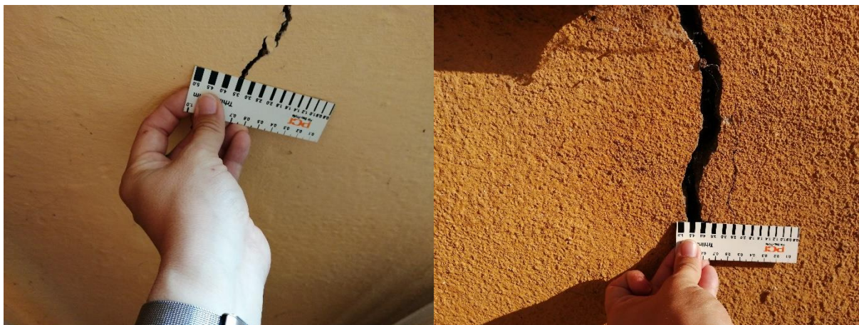
Obr. 3 Měření šířek trhlin, které souvisejí s rozdílným sedáním částí objektu
