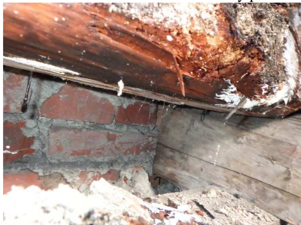
Foto č. 5 a 6 – sonda NV 2 – celkový pohled a detail napadení
