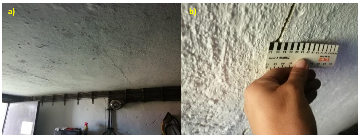
Obr. 25 Pravidelné trhliny v místě nosníků stropní konstrukce dílny – a) celkový pohled, b) měření šířky trhliny příložným měřítkem
