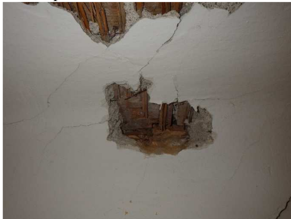
Foto č. 5 a 6 – sonda NV 2 – celkový pohled a detail napadení
