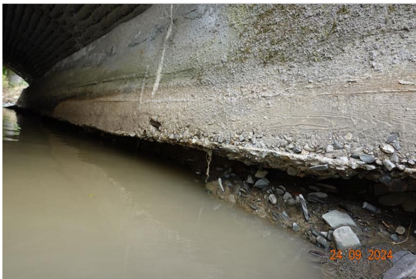
Detail OP2 v patě - podzemní opěry po povodni.
