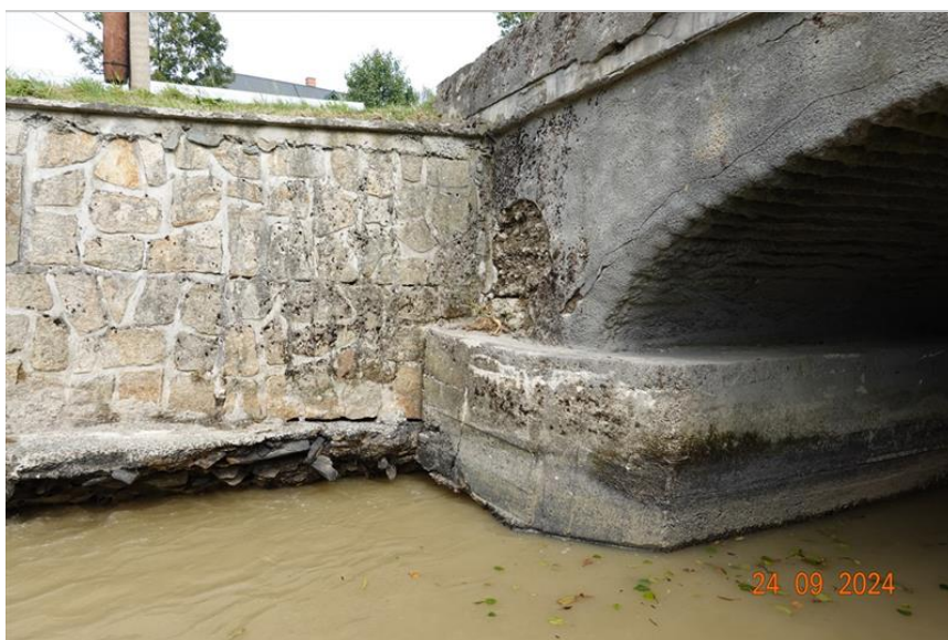
Pohled na OP1 a navazující nábrežní zeď zprava, naměřeno velmi silné podemletí cca 2,0m do hloubky a cca 2,5-3,0m do šířky pod vozovku - hrozí havárie pravé části mostu.
