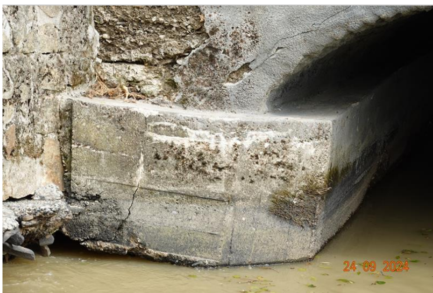
Detail OP1 v patě - trhliny (zhoršení trhlín po podemletí opěry po povodni).
