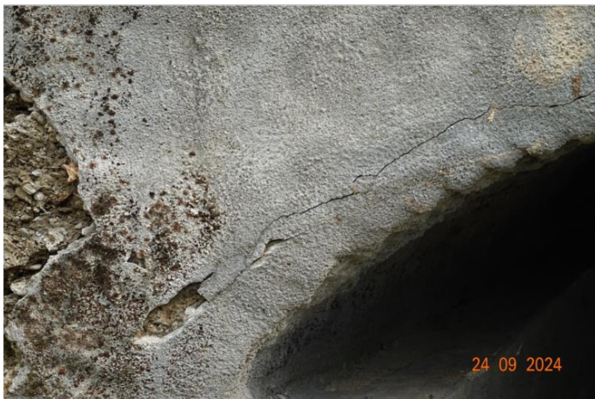
Detail čelní zdi u OP1 - trhliny - po povodni pravděpodobně došlo ke zhoršení.
