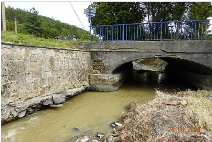
Pohled na nábrežní zed' na pravé straně a OP1, naměřeno podemletí do vzdálenosti cca 5,0m od mostu.
