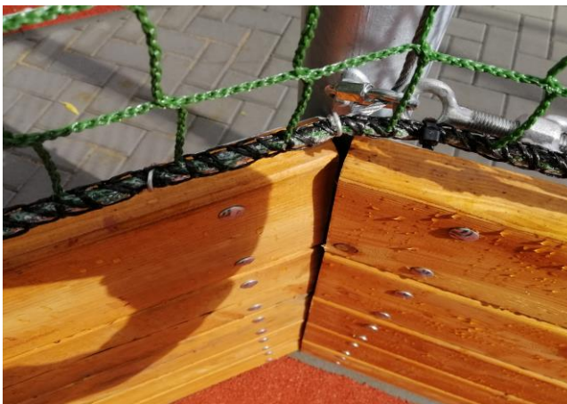
Chybně provedené napojení mantinelu v šikmém rohu
