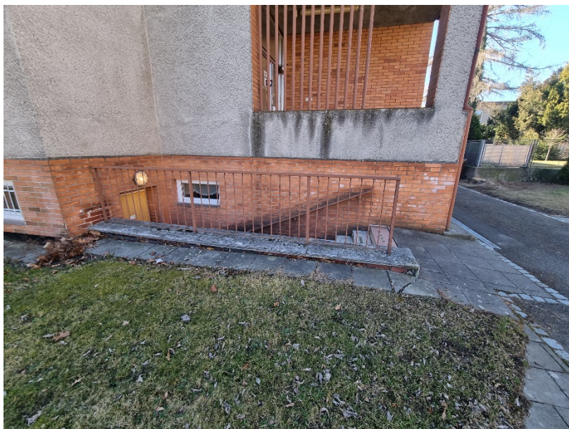
Prostor vstupního schodiště do 1.PP – schodišťová stěna obložená cementotřískovými deskami se zábradlím
