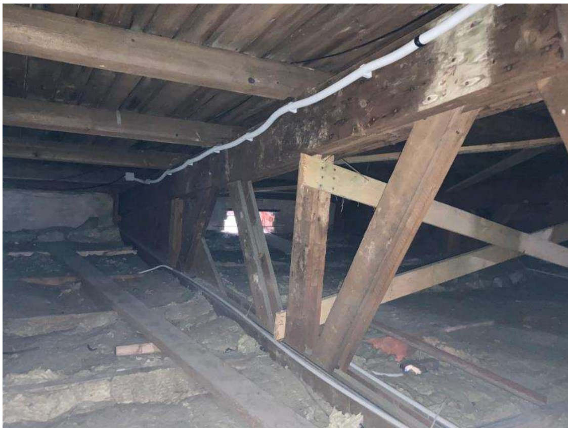
Obrázek 13: Pohled na vazník včetně uložení na zdivu
