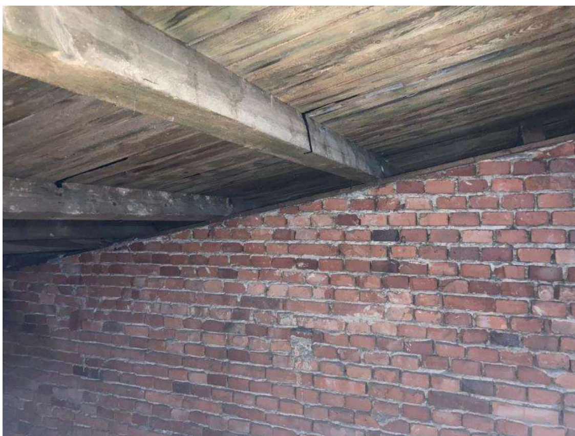
Obrázek 14: Pohled na ukončení krokví na štítovém zdivu
