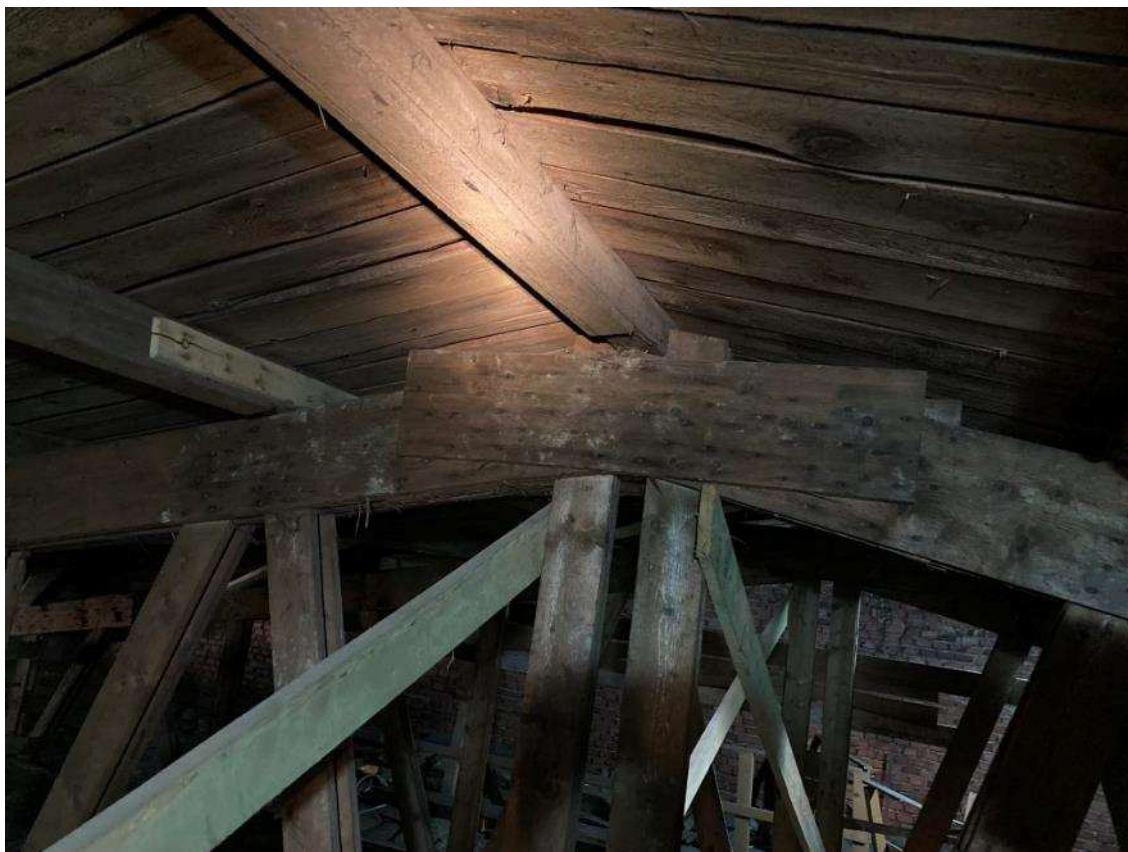
Obrázek 3: Vazník se zavětrováním – celkový pohled
