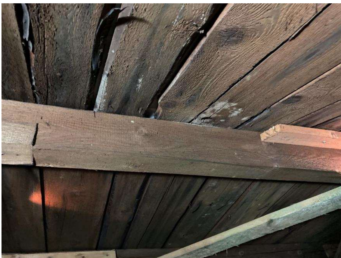
Obrázek 8: Detail osazení desek bednění střešního pláště – doplnění podpěry pro desky
