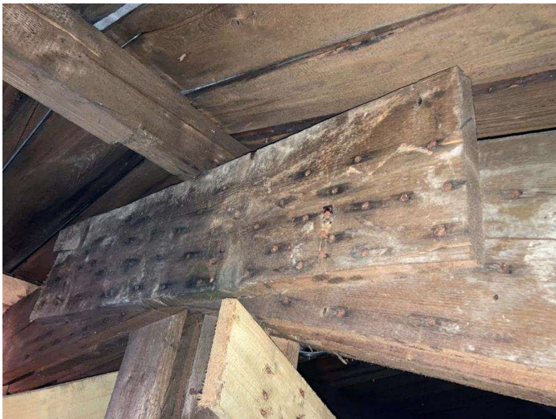
Obrázek 5: Detail příložky ve vrcholu vazníku a dodatečné zavětrování
