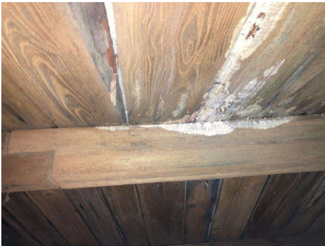
Obrázek 16: Zjištěné ložisko bílé hniloby ve vrcholu pláště v poli č. 4 (počítáno od prostupu)
