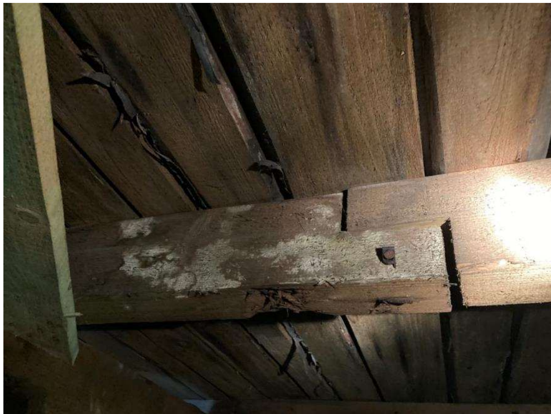
Obrázek 2: Spoj trámů – výskyt bílé plísně na povrchu trámu
