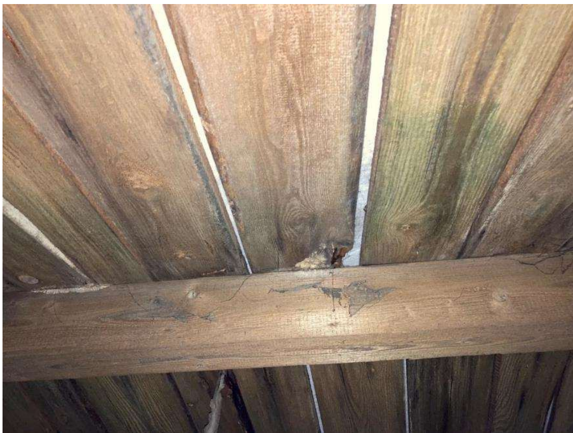
Obrázek 6: Detail uložení desek bednění pod střešním pláštěm – poškozená deska, plíseň
