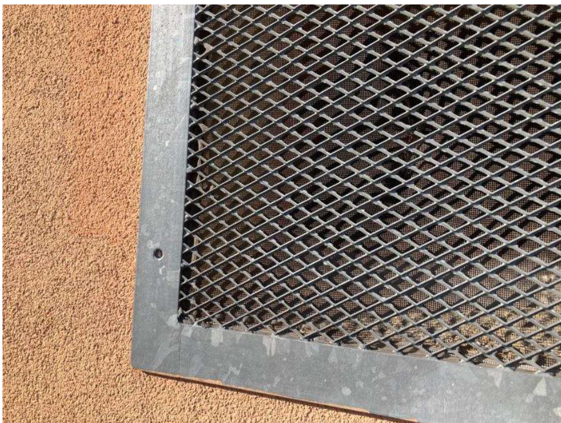
Obrázek 10: Ventilační mřížka na fasádě - detail
